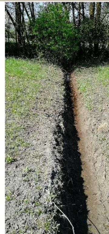
Iztočni del jarka, ob recipientu. Širina jarka: ~ 70 cm Globina jarka: ~40 cm
