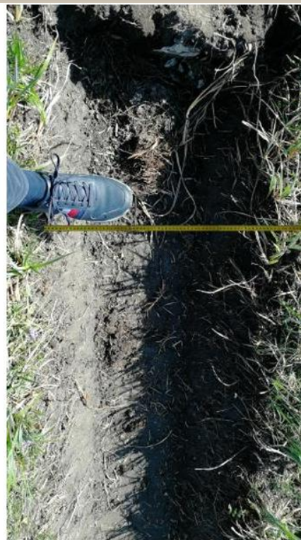
Začetek jarka (del jarka, ki je najbolj oddaljen od recipienta): Širina jarka: ~ 60 cm Globina jarka: ~30 cm
