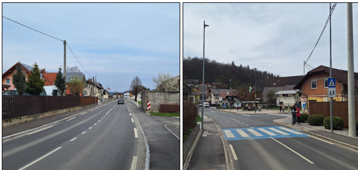
Slika 40: Cestno prometno omrežje v bližini stranske vstopne točke Ig Morostig (levo: ureditev državne regionalne ceste R3-642/1360 skozi naselje Ig, desno: območje križišča R3-642/1360 in Govekarjeve ceste - območje AP Ig)
