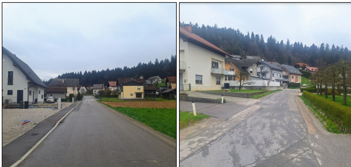
Slika 34: Cestno prometno omrežje v bližini stranske vstopne točke ŠP Bevke (levo: ureditev javne poti JP966861 v bližini navezave na LC468062, desno: ureditev lokalne ceste LC468062 v smeri proti območju Mali plac - izhodišče za Pot močvirskih škratov)
