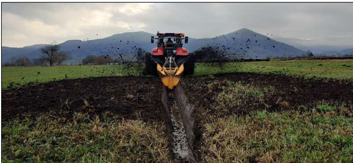
Slika 2: Izkop za dolgo linijsko mlako (foto: M. Pečovnik, 2022).
