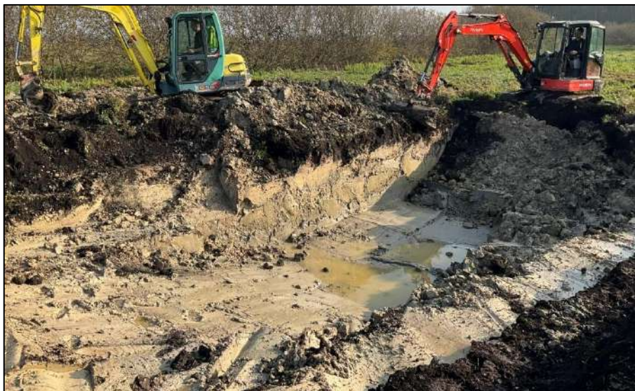
Slika 32: Pogled na TJ 15 (foto: L. Škerjanec, 2022).
