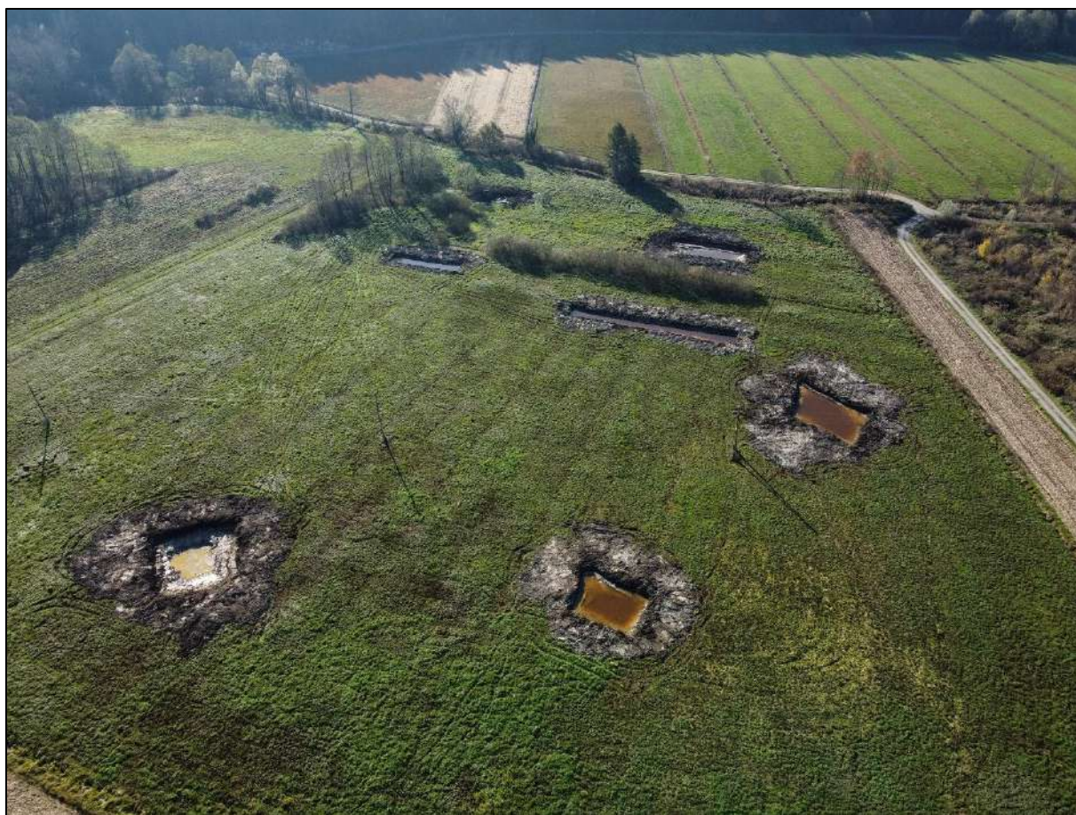
Slika 40: Pogled na izkope na območju parcele št. 2156, k. o. Tomišelj (foto: L. Škerjanec, 2022).
