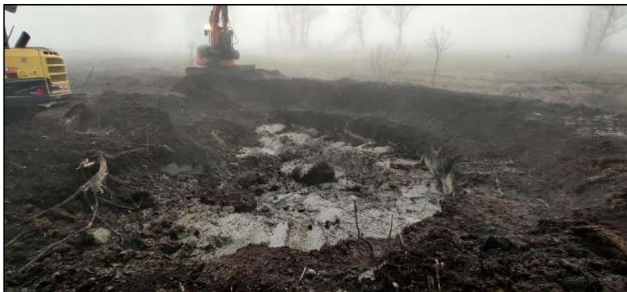
Slika 83: TJ 41 – izkop linijske mlake z bazenom (foto: P. Tible, 2023).
