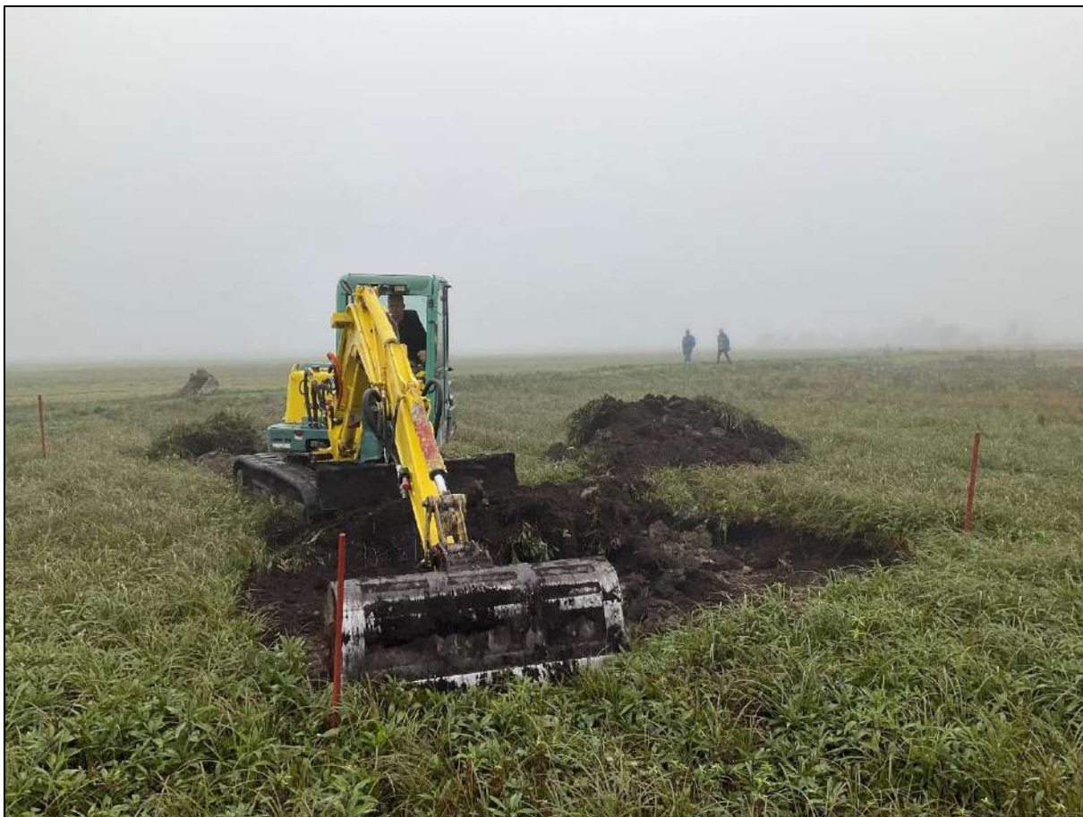
Slika 1: Strojni izkop za mlako (foto: L. Škerjanec, 2022).
