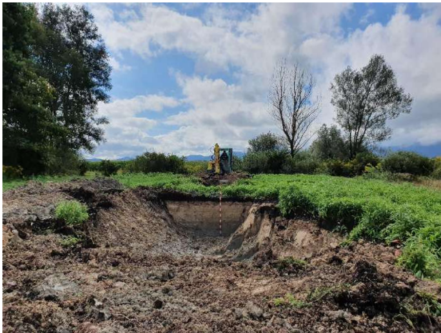
Slika 4: Pogled na izkopano mlako na lokaciji št. 19. Foto: Bogo Klezin. Izvajalec raziskave: Avgusta d.o.o.
