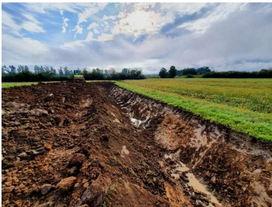
Slika 5: Pogled na izkopani na razširjen in poglobljen terciarni jarek na lokaciji 10. Foto: Bogo Klezin. Izvajalec raziskave: Avgusta d.o.o.
