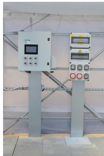
Slika 4. Sistem za oddaljen avtomatski nadzor s senzorji za veter, dež, temperaturo in vlago v gojilnici.
