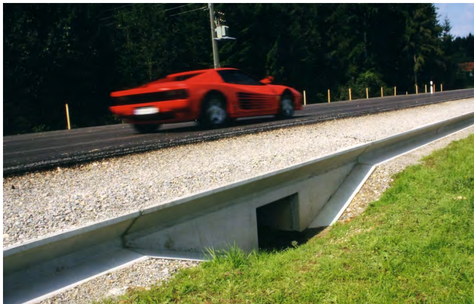
Slika 18: Ograje za dvoživke (povzeto po katalogu Zieger) – pravilen način pripenjanja ograje na vhod podhoda.
