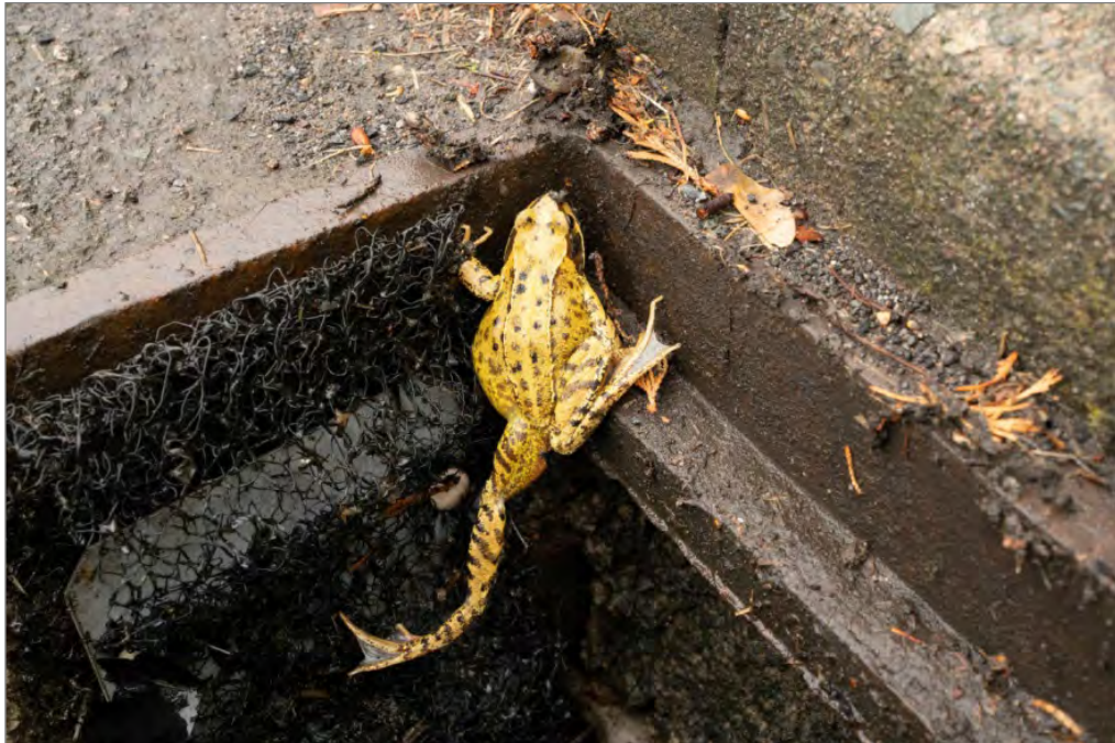
Slika 21: Prikaz uporabe Enkamat mreže za reševanje dvoživk iz različnih tipov jaškov (Reuters, 2018).
