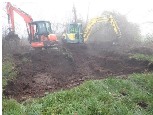
Slika 12: Začetek izkopa mlake - odstranjevanje zgornje plasti
