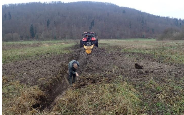
Slika 11: Izkop ožje linijske mlake z traktorskim priključkom jarkačem in delo arheologa
