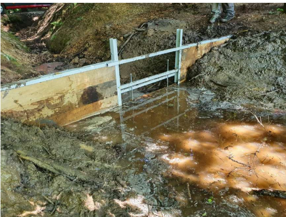
Slika 14: Namestitev vodne zapornice na iztoku barja Mali plac (18.6.2020).
