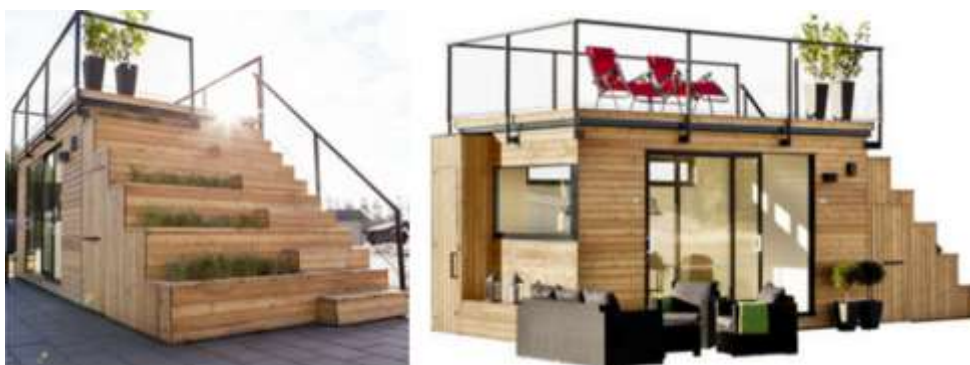
Slika 83: Primer ureditve manjše bivalne enote na Švedskem, kjer so ravno streho izkoristili za teraso. Poleg stopnic so inovativno umestili tudi korita za rastline, s čimer so celoten objekt še bolj približali naravi (Living in a shoebox, 2013).
