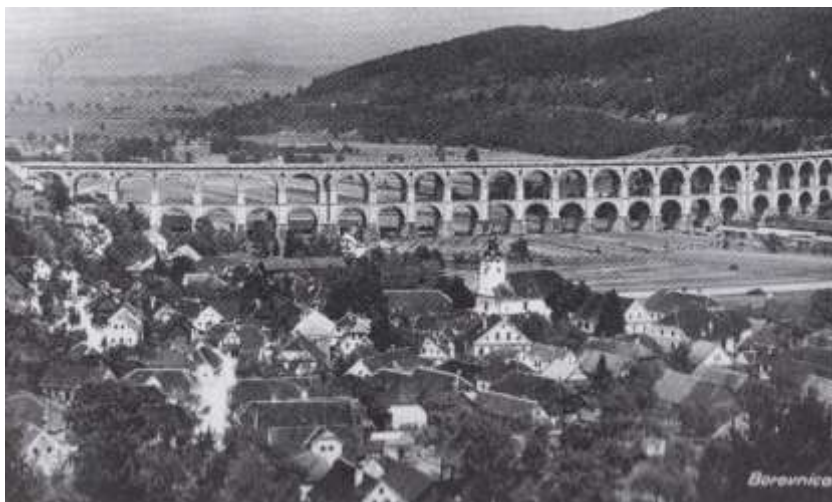
Slika 44: Borovniški viadukt je bil največji objekt na progi južne železnice med Dunajem in Trstom (Drobnič, 2007).
