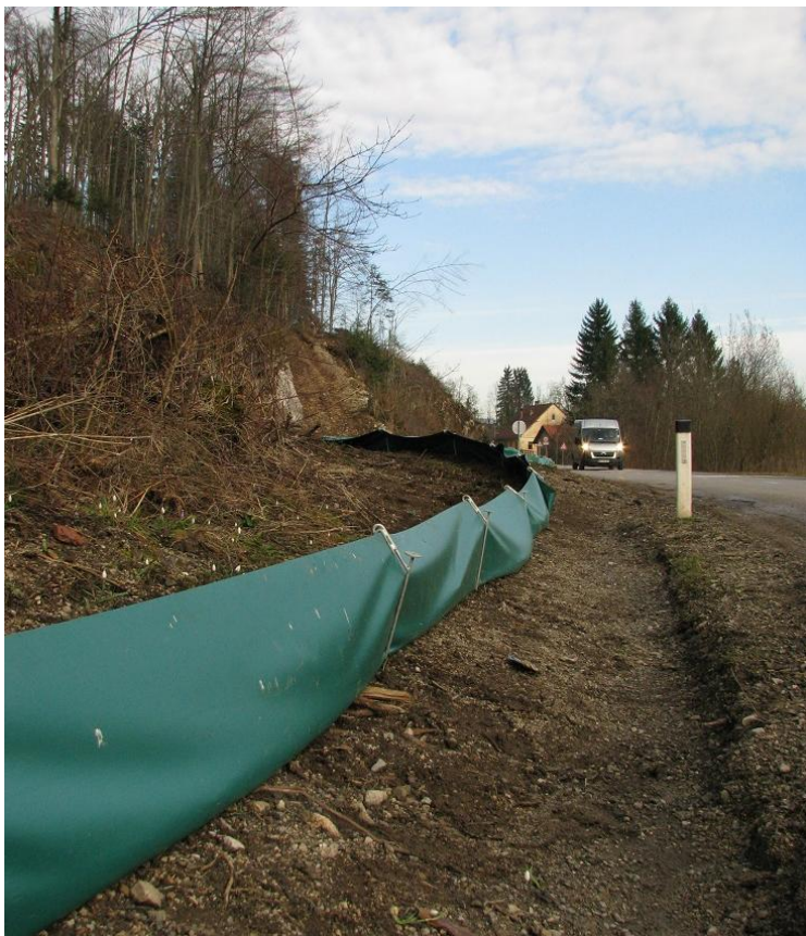
Slika 3: Začasna ograja za dvoživke, postavljena na odseku Bistra.
