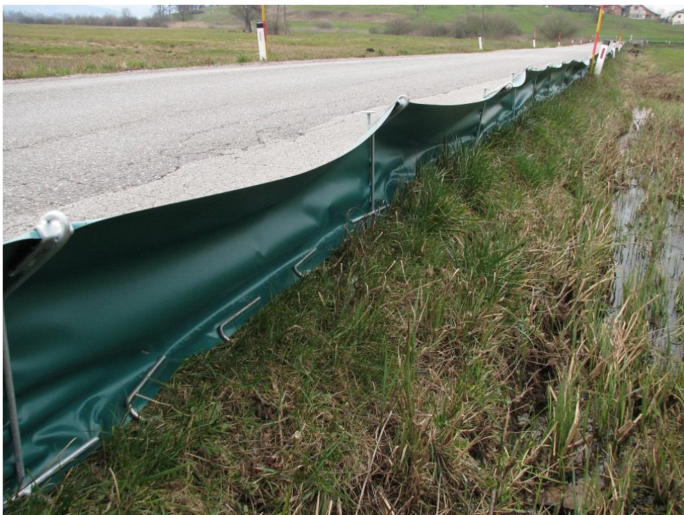
Slika 3: Dodatni pritrdilni elementi ograje, ki dvoživkam preprečujejo prehod pod ograjo.
