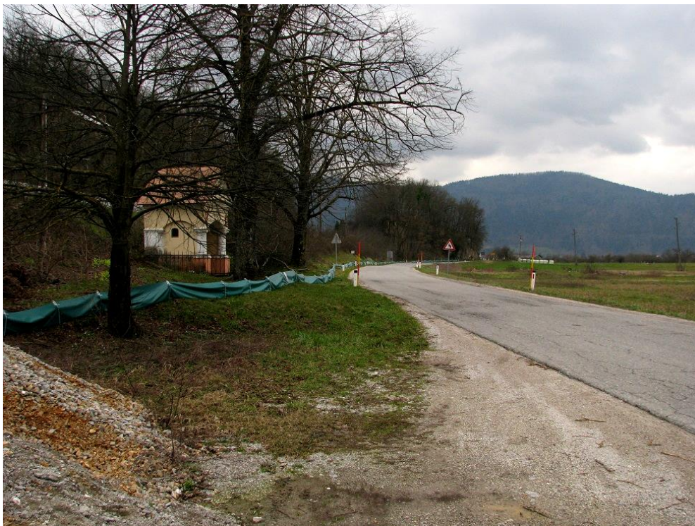
Slika 2: Začasna ograja za dvoživke, postavljena na odseku Pako – Goričica.
