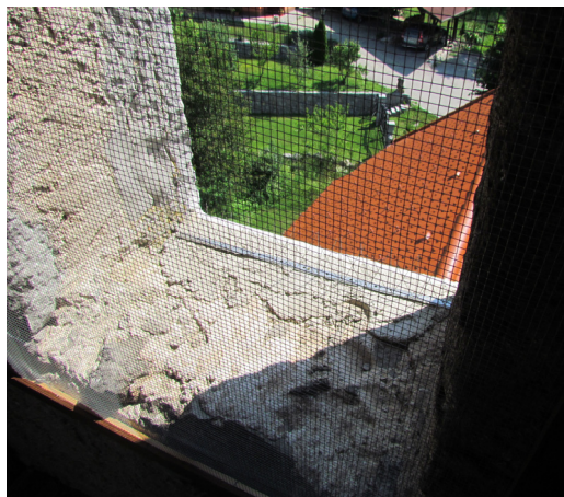
Slika 1. Zamreženje večjih odprtin z gosto mrežo in namestitve zaščitnih špic, ki preprečujejo pristajanje golobov na zvonišču cerkve sv. Mihael v Iški vasi (foto: Primož Presetnik, 28.6.2014).
