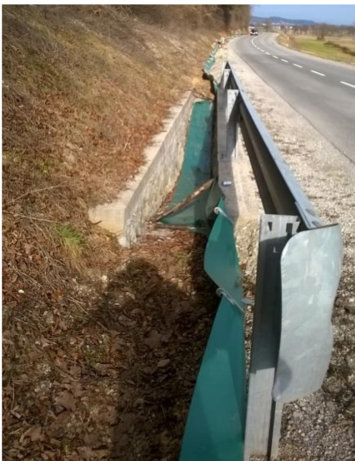
Slika 5: Začasna ograja za dvoživke, postavljena na odseku Bevke.
