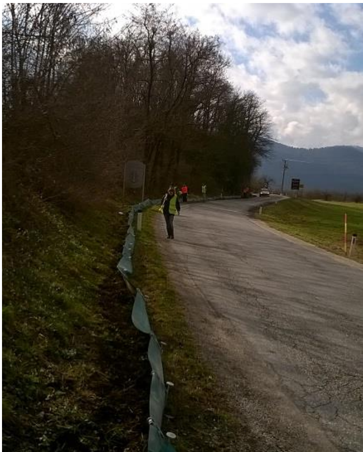
Slika 4: Začasna ograja za dvoživke, postavljena na odseku Pako-Goričica.
