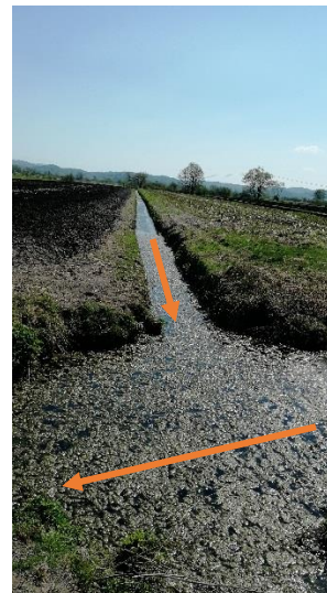
Iztočni del jarka. Voda iz jarka se izliva v obstoječi melioracijski jarek (kasneje imenovan »Melioracijski jarek«). Širina obnovljenega jarka je cca 150 cm. Globina jarka: ~110 cm
