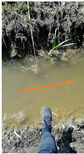
Jarek napolnjen z vodo: Dimenzije: - širina zgoraj: 130-150 cm; - globina zračnega dela jarka: 50 – 65 cm; - globina vode do mulja: 25 cm; - globina mulja: 25 cm Globina kopa jarka ob izvedbi: 90-110 cm
