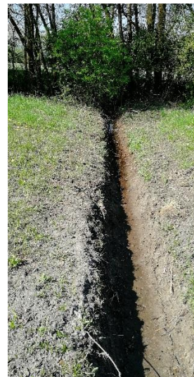
Iztočni del jarka, ob recipientu. Širina jarka: ~ 70 cm Globina jarka: ~ 40 cm
