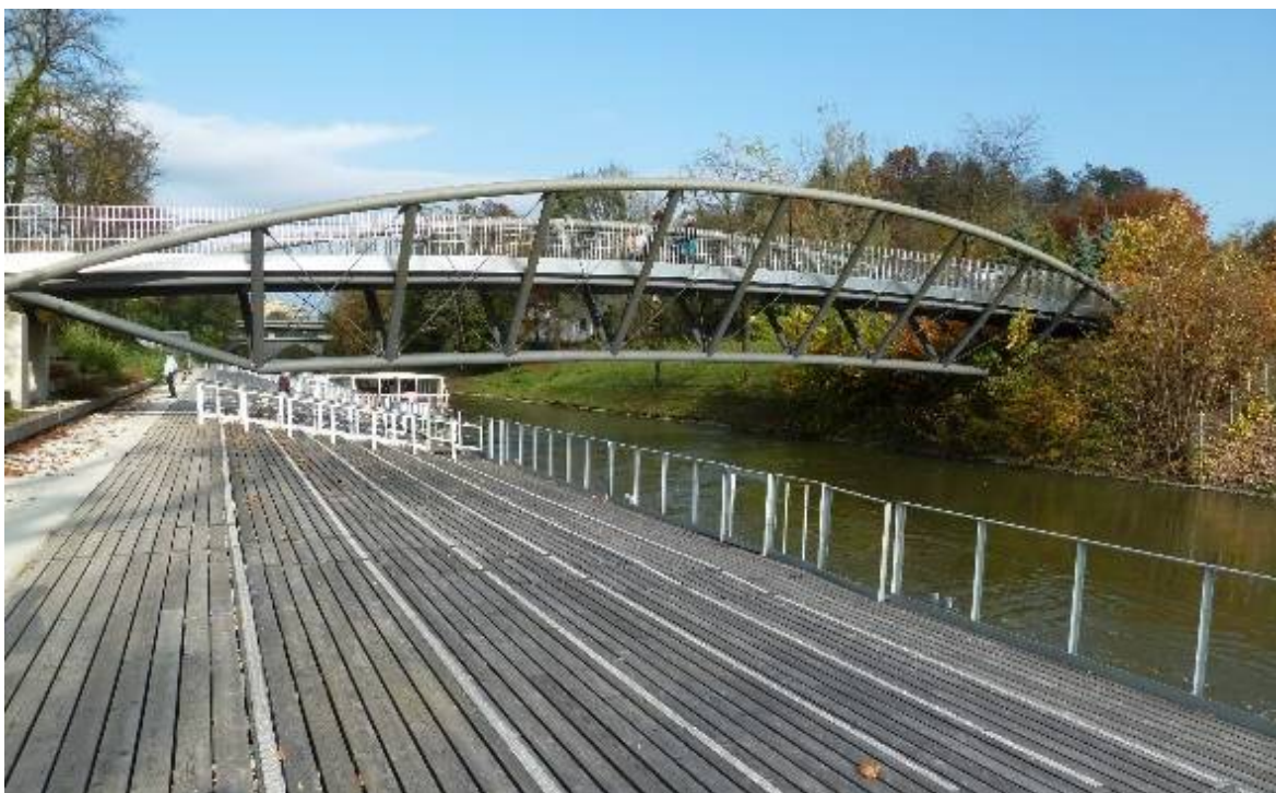
Slika 6-2: Pristanišče na Gruberjevem Prekopu (Foto: DRSV, 27. 10. 2016)
