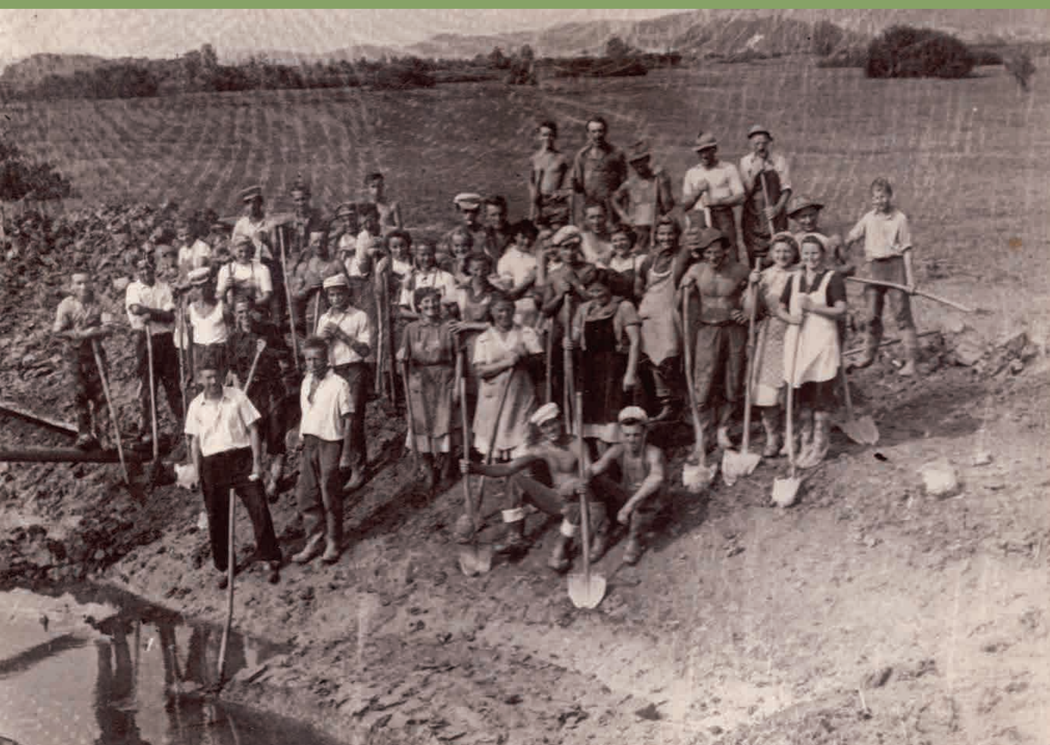
Grabnarji ob Želimeljščici kmalu po 2. svetovni vojni. Osuševalne jarke - "grabne" so za dodaten zaslužek kopali v času, ko ni bilo večjih kmečkih del. V zadnjih dvesto letih je bilo na Ljubljanskem barju izkopanih skoraj 5 tisoč kilometrov jarkov. Vir: Amalija Kovačič, Arhiv Interesnega združenja Naša Lavrica
