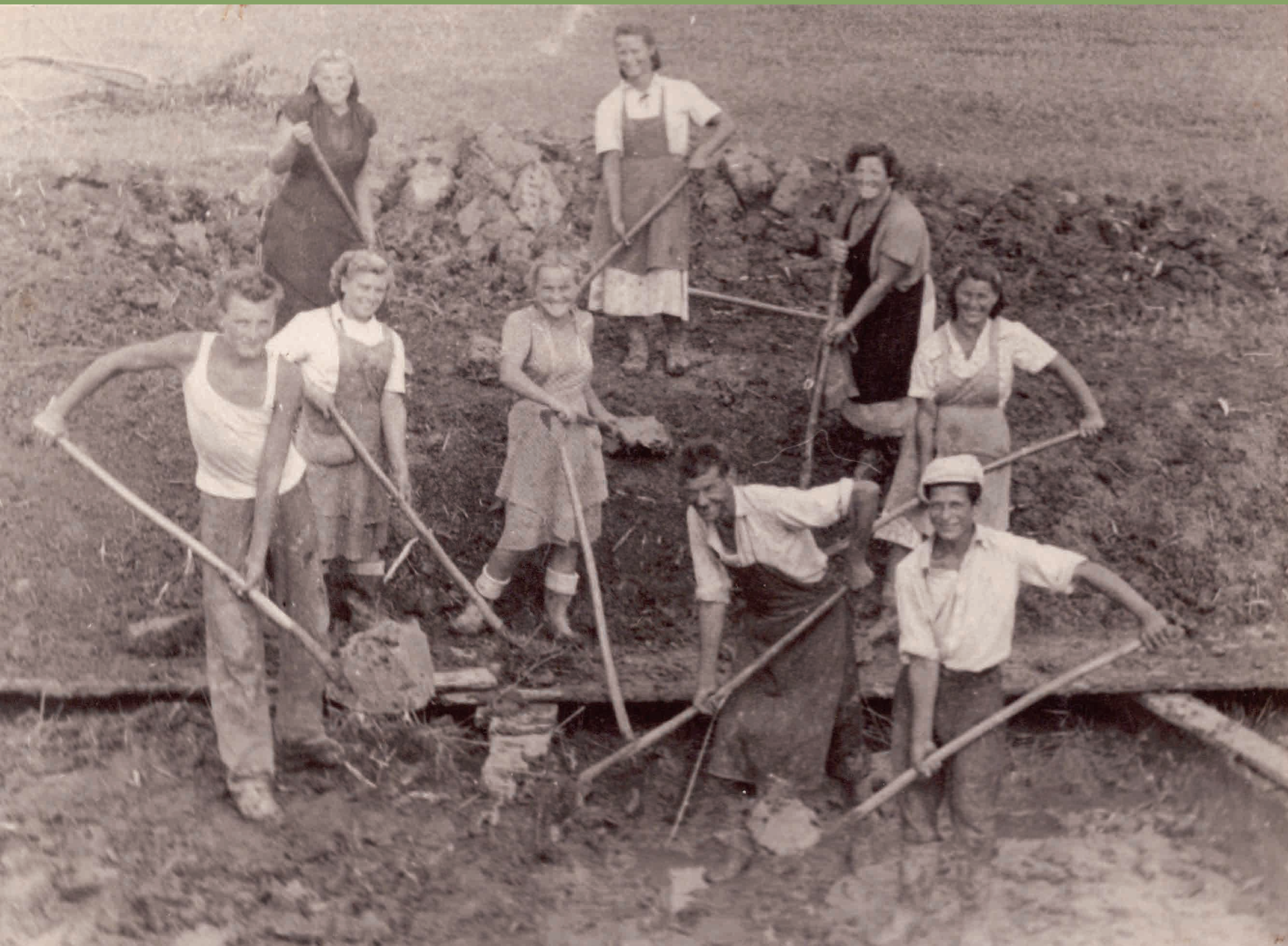
Grabnarji ob Želimeljščici kmalu po 2. svetovni vojni. Osuševalne jarke - "grabne" so za dodaten zaslužek kopali v času, ko ni bilo večjih kmečkih del. V zadnjih dvesto letih je bilo na Ljubljanskem barju izkopanih skoraj 5 tisoč kilometrov jarkov. Vir: Amalija Kovačič, Arhiv Interesnega združenja Naša Lavrica
