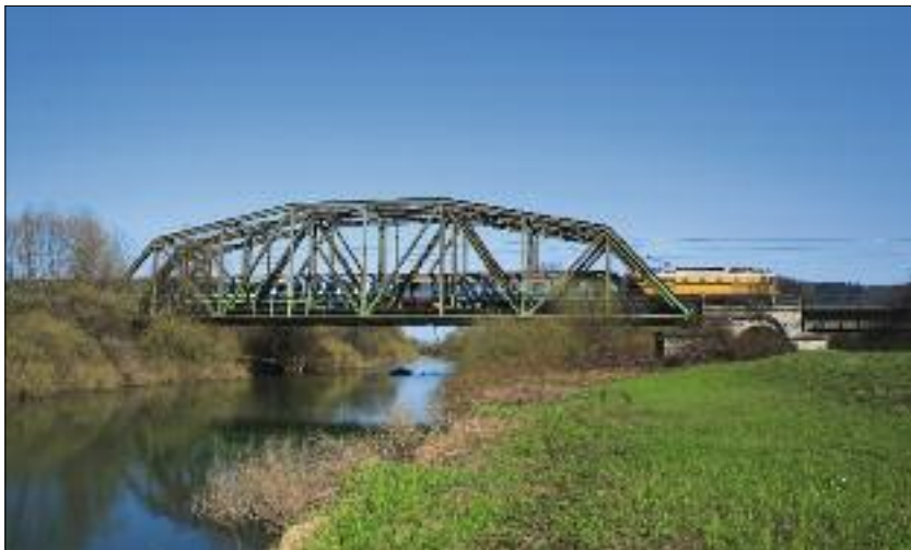
Slika 28: Železniški most čez Ljubljanico pri Kamniku pod Krimom. Do leta 1857 zgrajeno leseno konstrukcijo je ob koncu 19. stoletja zamenjala železna.
