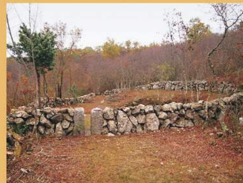
„Stuba“ u suhozidu oko lokve Živa omogućava prolaz ljudima, a zadržava stoku (Foto: Patrik Krstinić)
